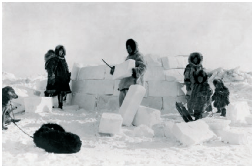
Inuites construindo um iglu. (Frank E. Kleinschmidt, 1924)
